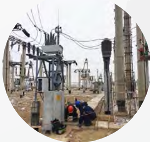
ПОДСТАНЦИОННЫЙ ВЫКЛЮЧАТЕЛЬ
