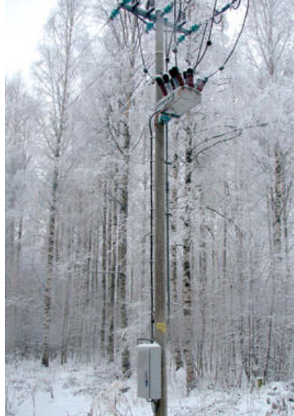
ВАКУУМНЫЙ РЕКЛОУЗЕР OSM И ШКАФ УПРАВЛЕНИЯ RC
