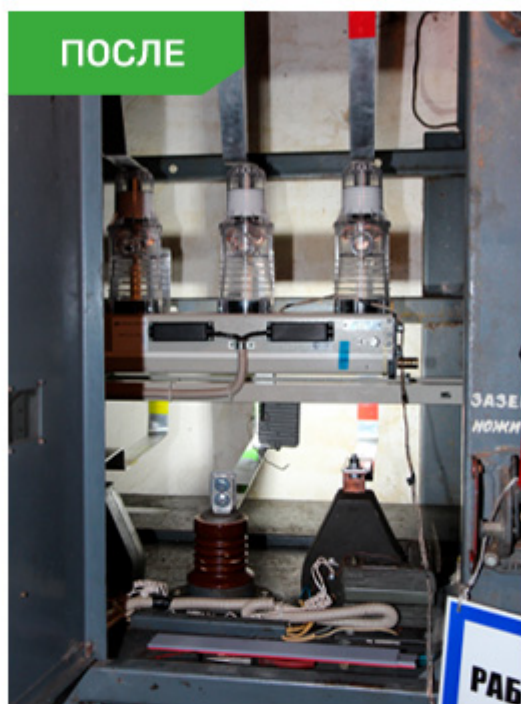
Вакуумный выключатель
